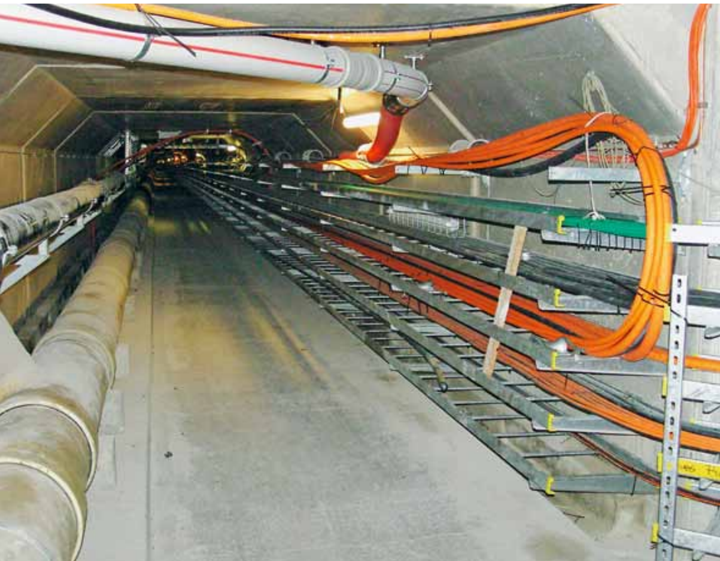
Im Kabelkanal werden die Kabel verlegt.
