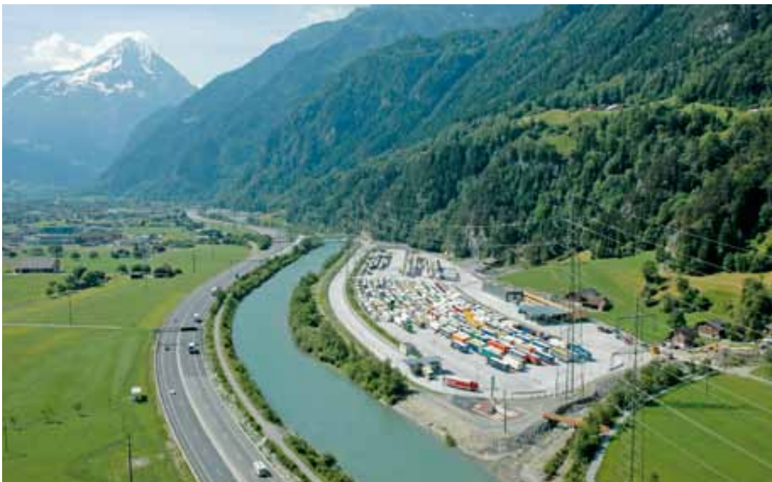
Das Schwerverkehrs-Kontrollzentrum in Ripschausen UR.
