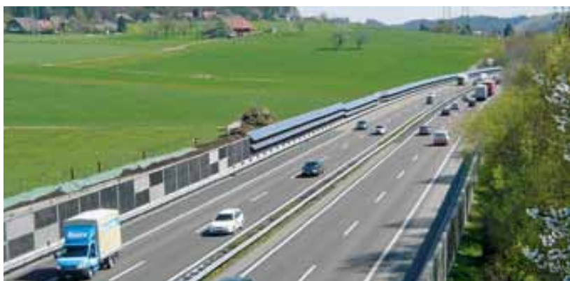
Photovoltaik auf der Lärmschutzwand von Safenwil AG.
